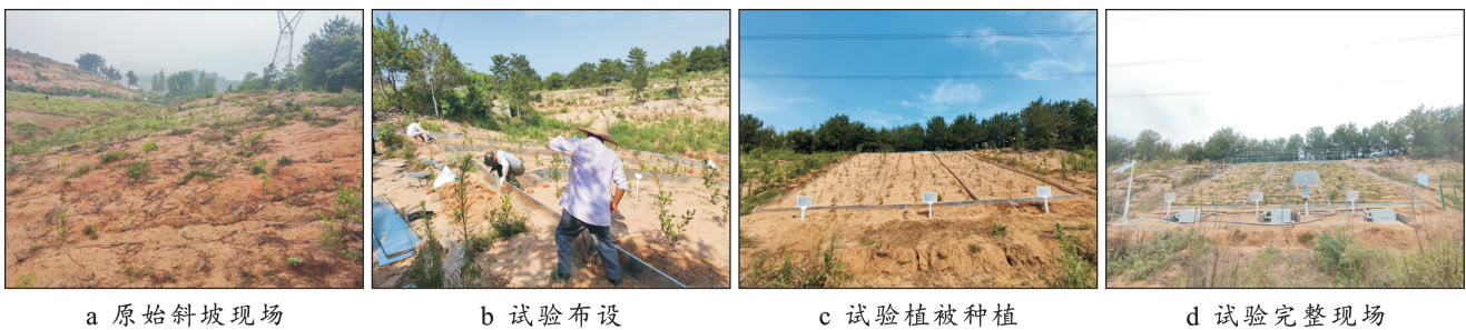
图 1 原位降雨试验现场
